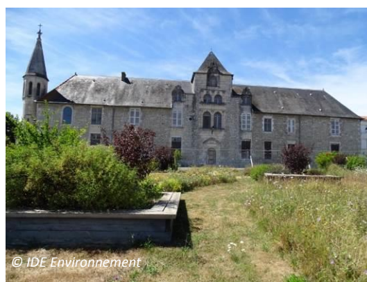
Logis du commandeur – Août 2016
