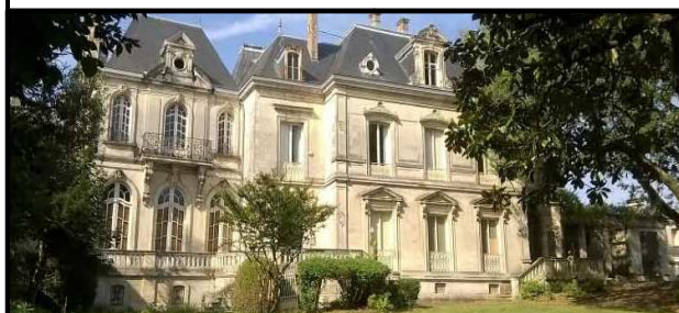
Réhabilitation de la Villa Musso
