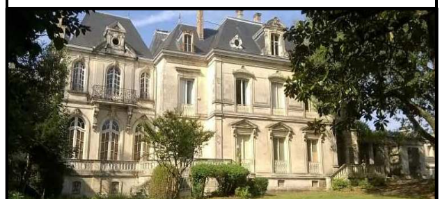
Réhabilitation de la Villa Musso
