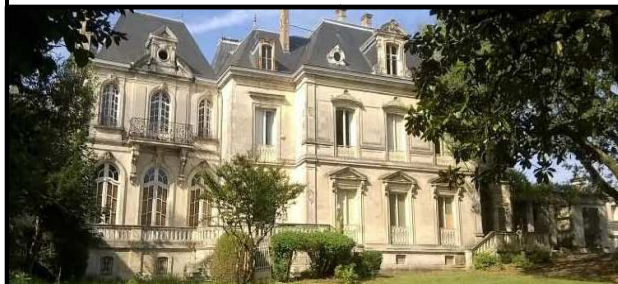
Réhabilitation de la Villa Musso
