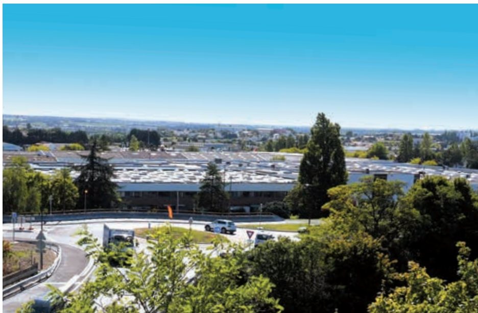
Le bâtiment de l'ancienne usine Saintronic, une friche à reconquérir.
