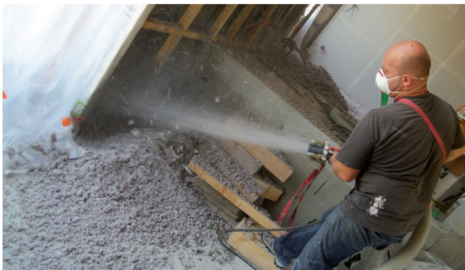
La technique du soufflage a été utilisée pour renforcer l'isolation des combles dans les écoles (photo d'illustration).
