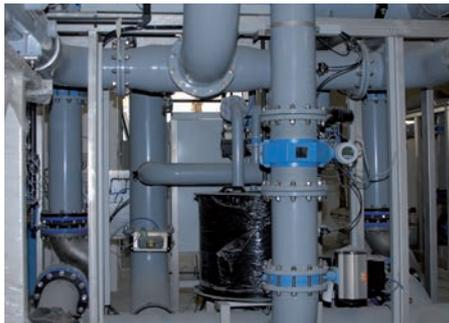
► En 2008, la Ville de Saintes a modernisé l'usine de potabilisation de l'eau. Cette modernisation a porté notamment sur la décarbonatation, c'est-à-dire l'adoucissement de l'eau (la réduction du degré de calcaire).
