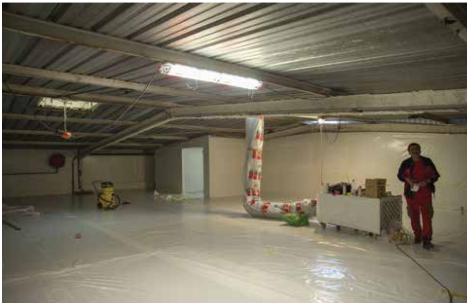
Un bâtiment de l'ex-Charentaise en cours de désamiantage, fin avril, avant sa démolition.
