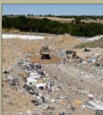
NUISANCE. Les températures élevées et le vent ont amplifié les problèmes d'odeur.
