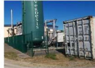
De plus, début 2018, le CVD s'est équipé d'une **plateforme de traitement des biogaz par charbons actifs imprégnés**.
