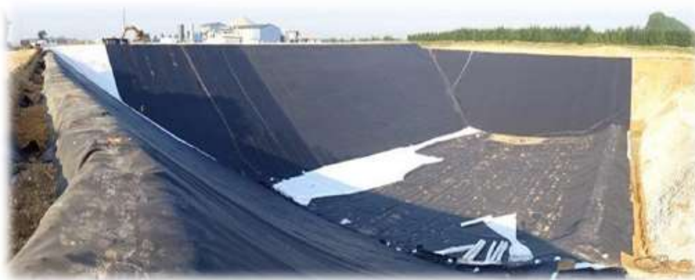
Figure : Barrière de sécurité passive
